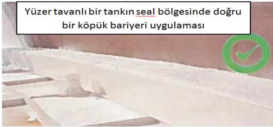
Şekil 32 Doğru Köpük bariyeri tasarımı uygulaması
