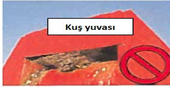
Şekil 34 Kuş Yuvası nedeniyle tıkanmış köpük dökücü
