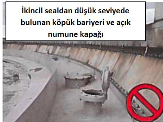
Şekil 36 Köpük bariyeri dizayn hatası
